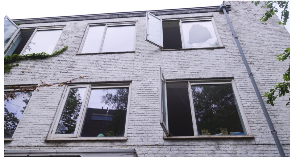
Detail van de vensters op de eerste en tweede verdieping in de zuidgevel van het voorste deel.
