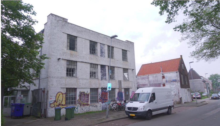
De voorgevel aan de Oostvest.
