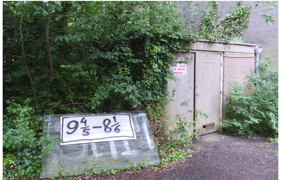
Achter de erfscheidingsmuur is nog een berging aanwezig.
