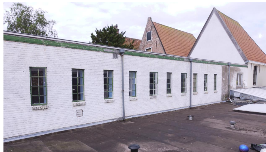
Zicht op de noordelijke zijgevel bij het bouwdeel uit 1935, gezien naar de Houtmarkt.
