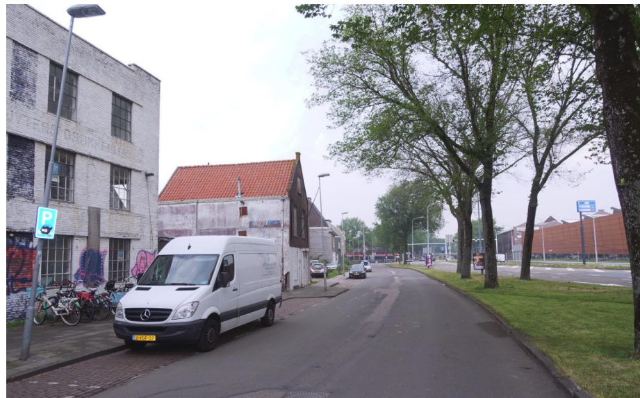
Zicht op de Oostvest gezien richting het noorden met links de voorgevel van het in dit rapport onderzochte pand.
