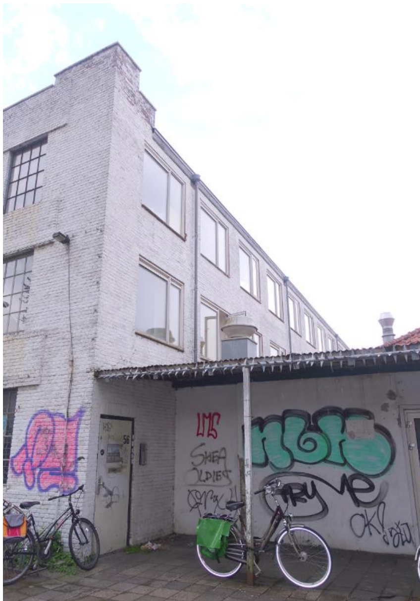
Zicht op de noordgevel bij het voorste deel, gezien vanaf de Oostvest. De entree op de begane grond is uit 1954.
