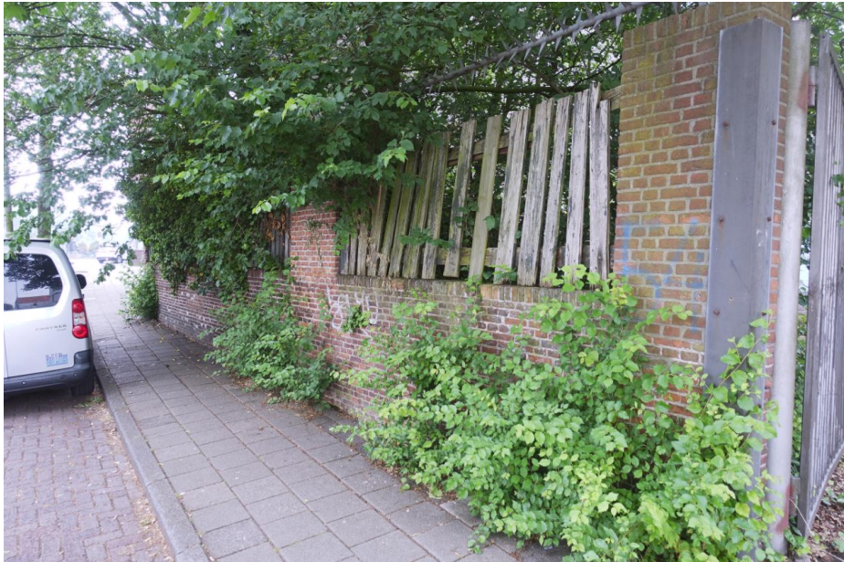
De erfscheidingsmuur aan de Oostvest ten zuiden van het gebouw.
