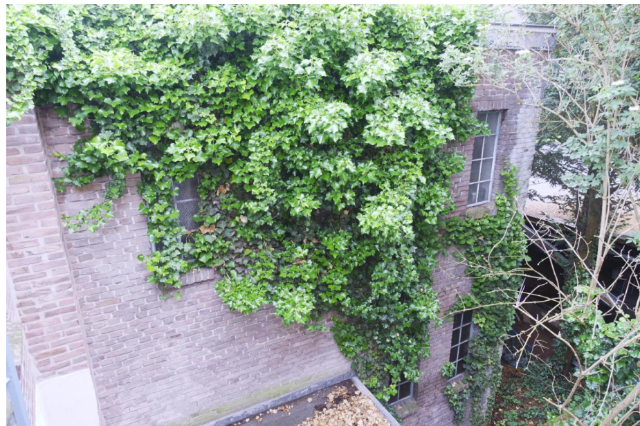
De achtergevel van het achterste deel kijkt deels uit op een binnentuin die achter Houtmarkt 7 is gelegen en bezit nog de oorspronkelijke vensters met vulling.
