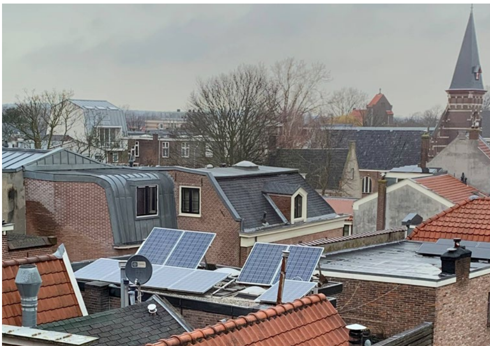
Panelen op platte daken in binnenstad
