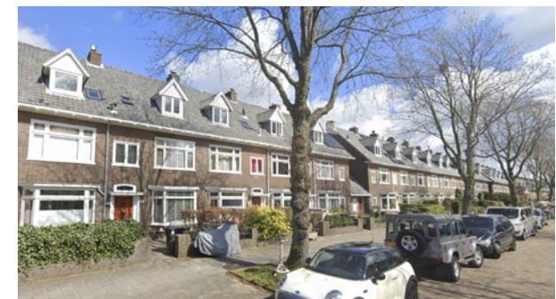
Doorlopende dakvlakken van complexmatig ontwikkelde woningen in Haarlem Noord, Zaenenlaan
