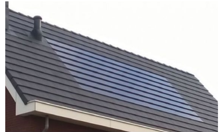
zonnepanelen geïntegreerd in het dak
