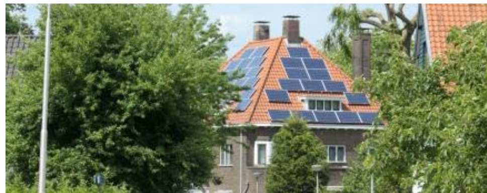
Verrommeling van het beeld als gevolg van plaatsing van zonnepanelen
