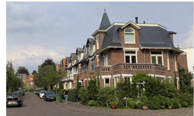
Samengestelde kapvorm als sprekend onderdeel van de architectuur met dakkapellen en torentjes
