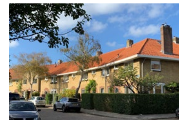
Haarlem-Noord, Hedastraat met woningbouwcomplex uit 1920
