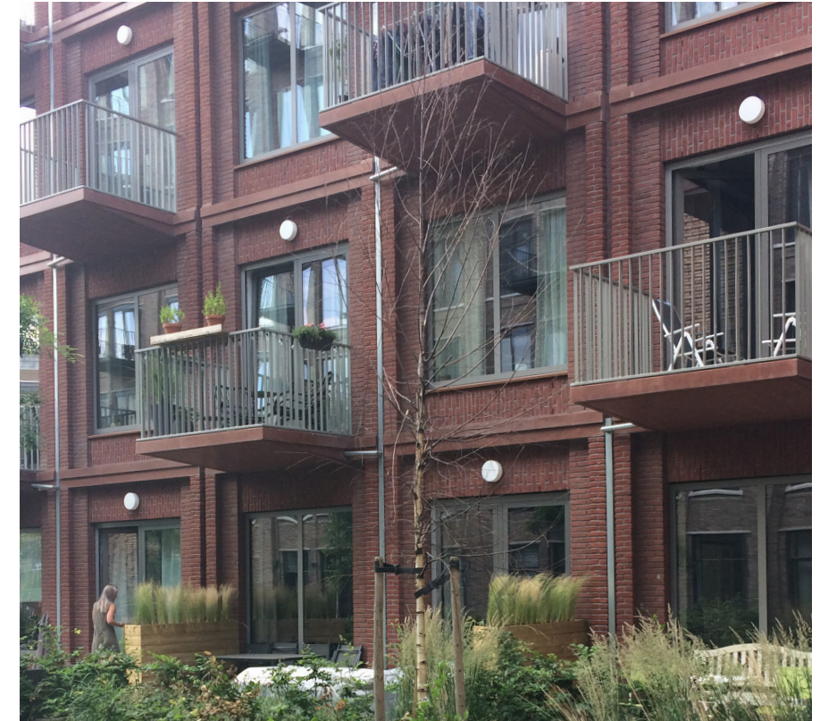
Gelaagdheid van de gevel en compositie van de balkons
