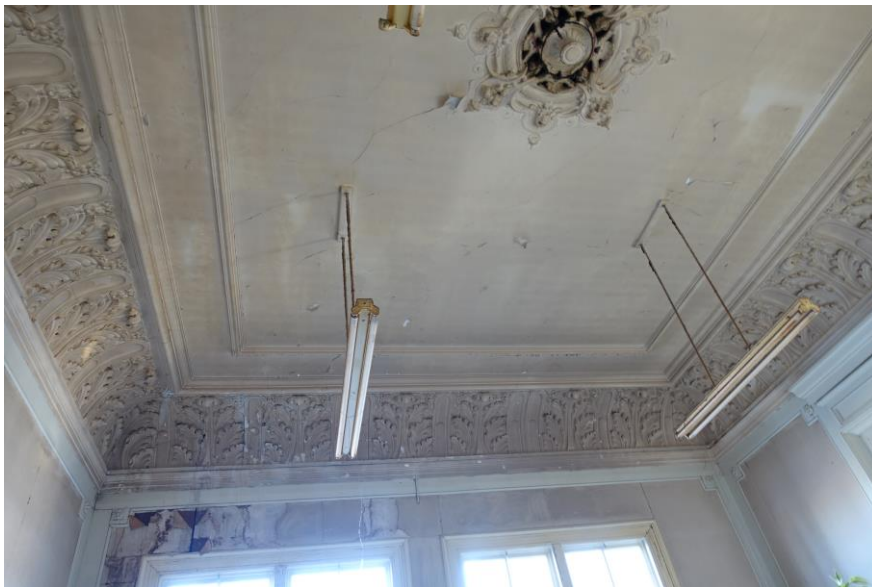
Het stucplafond van de achterzaal naar de zijgevel gezien.
