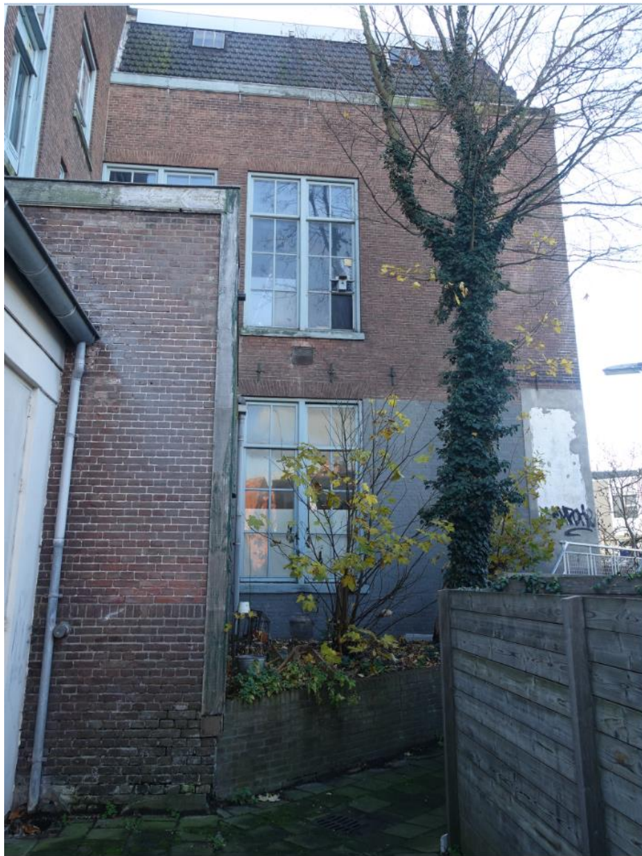
De zijgevel van de achterbouw
