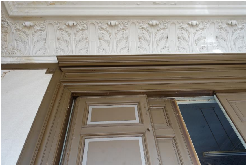
Detail kooflijst en en suite deuren van de voorzaal.
