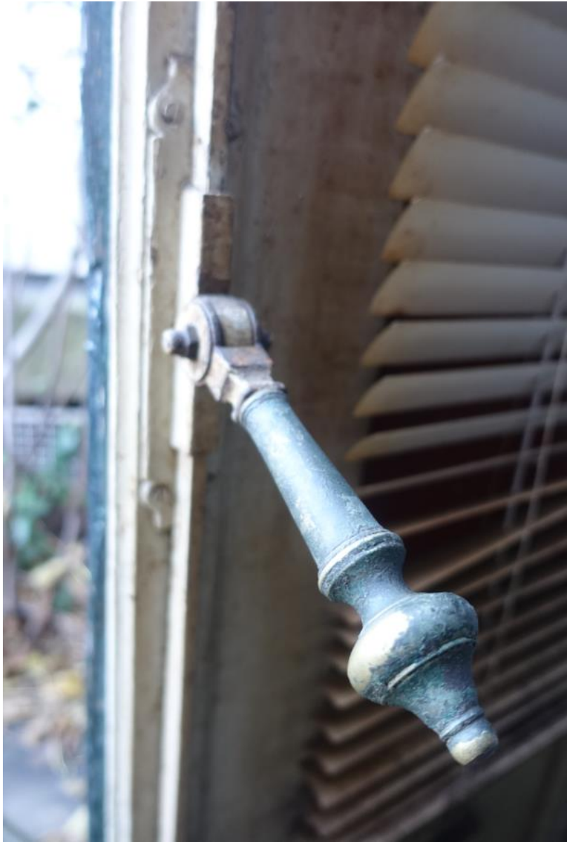
Metalen (koper) kruk van espanolet van de achterdeuren.
