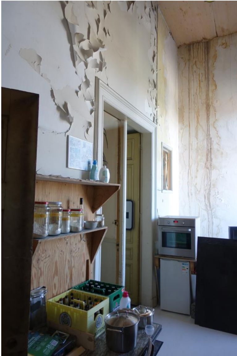
De deuren naar de zaal en in 1951 gebouwde gang vanuit de overloop gezien.
