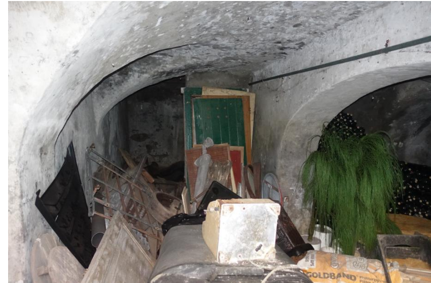
Linker deel van de kelder gezien richting achtergevel. FH MAB 2018
