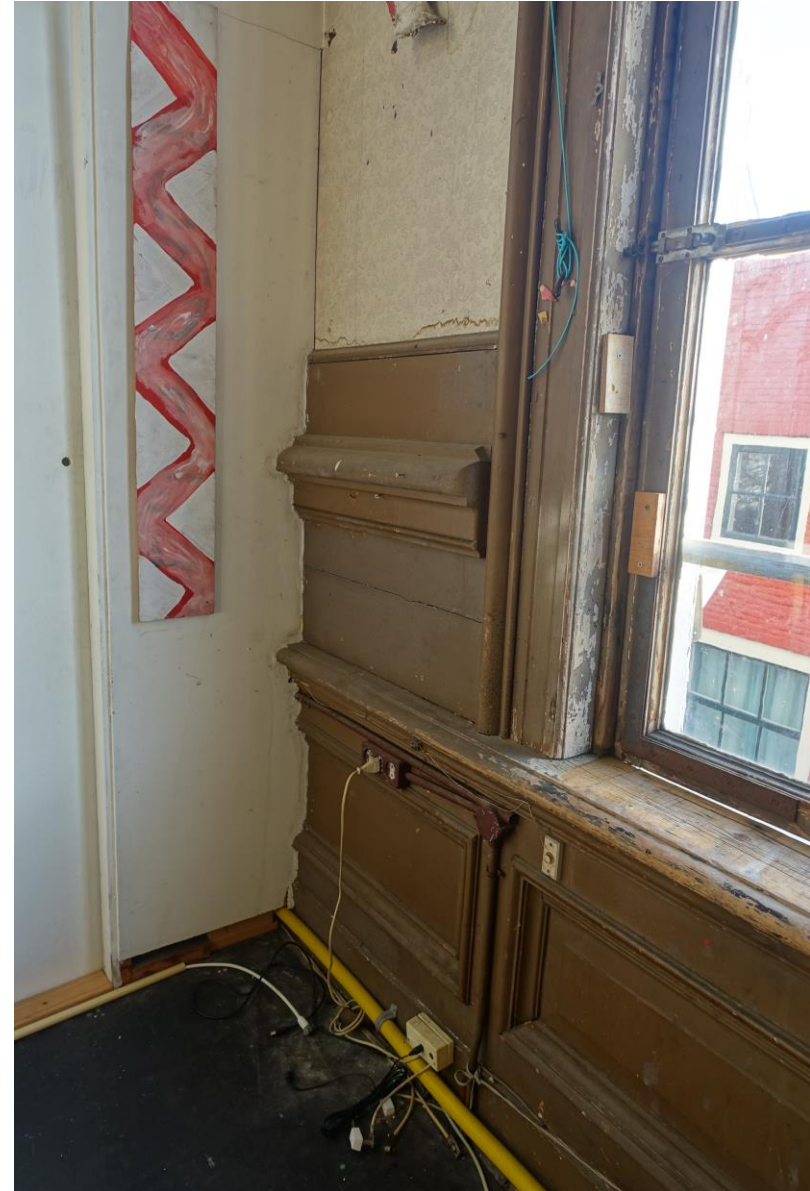
Vensterbetimmering en lambrisering voorzaal bij de voorgevel.
