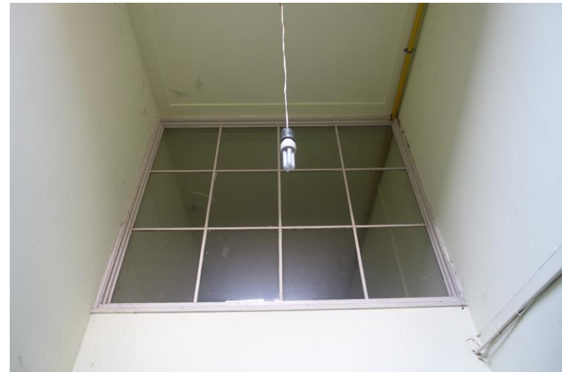
Bovenlicht van tochtpui uit 1951 in linker gang.
