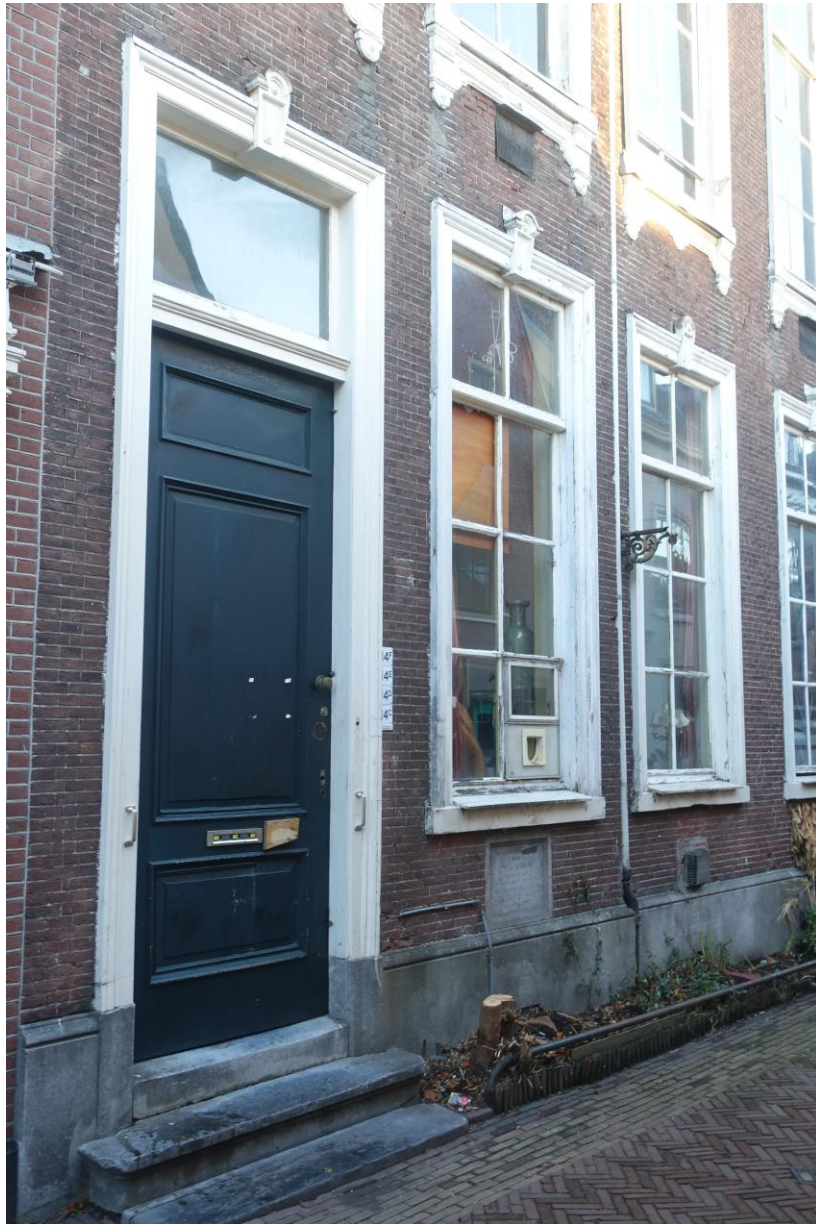
De linker voordeur en aansluitende vensters van de voorgevel.
