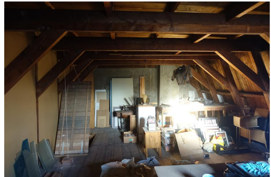
De zolder in het rechter deel naar achteren gezien.
