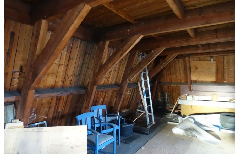
Zolder linkerdeel achterbouw naar achteren gezien.
