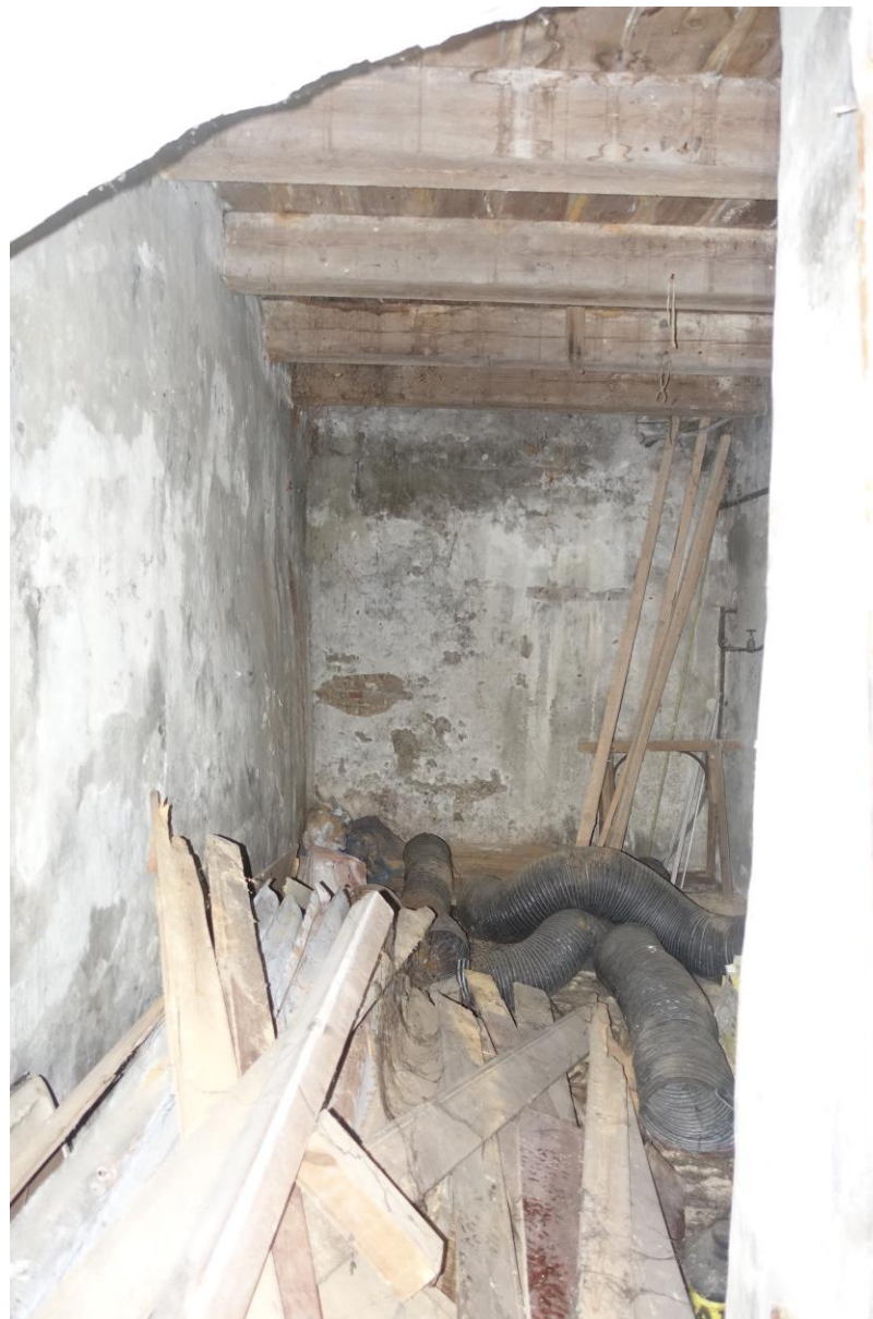
Kelder, achterbouw met balkenplafond.
