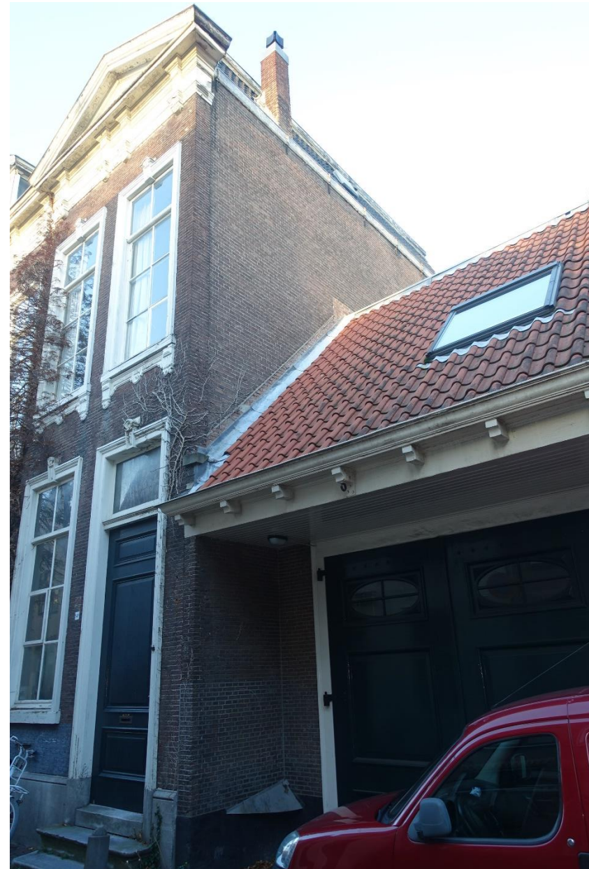
De rechter hoek van de voorgevel en zijgevel.
