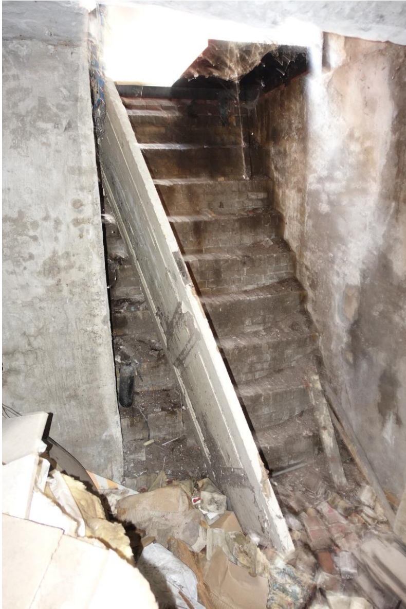
Kelder, trap onder voorgevel.
