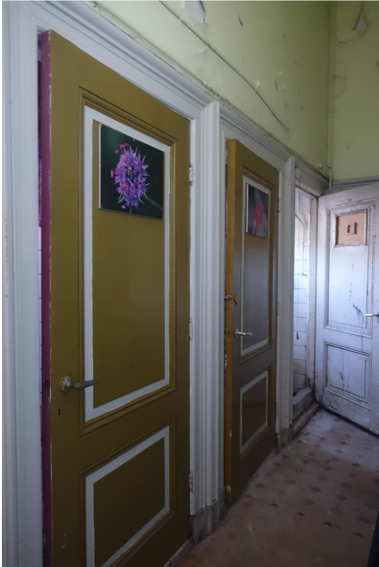
Gekoppelde deuren van toiletten in dwarsgang achterbouw.
