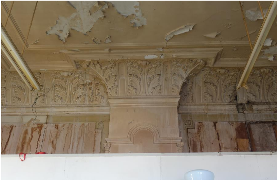
Schouwboezem en kooflijst plafond van de achterzaal. FH MAB 2018
