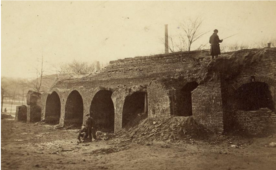
Zicht op de middeleeuwse stadsmuur ter hoogte van de Kinderhuisvest bij de hoek Nieuwe Gracht, tijdens de sloop in 1873. NHA beeldbank, nr. KNA006012642.
