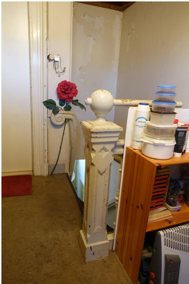
Trapaansluiting met trappaal op de voorgrond in de overloop van de voormalige secretarie.
