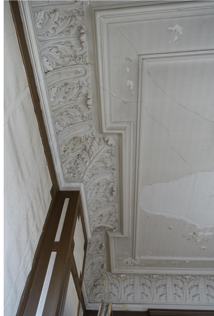
De boezem en kooflijst van het plafond in de voorzaal.
