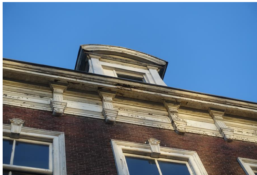
Middendeel voorgevel met dakkapel.
