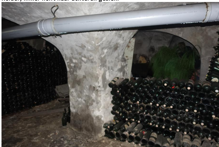
Kelder, vrijstaande pijler in rechter deel.
