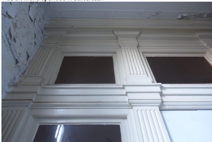
Detail van de oorspronkelijke wand tussen de klaslokalen.
