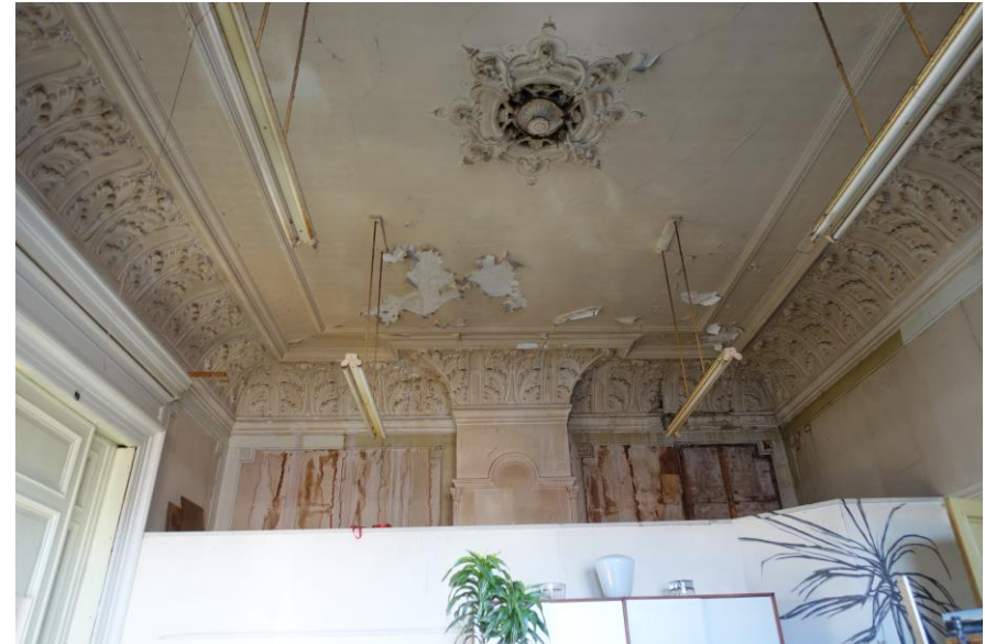
Het stucplafond van de achterzaal naar de andere zijgevel gezien.
