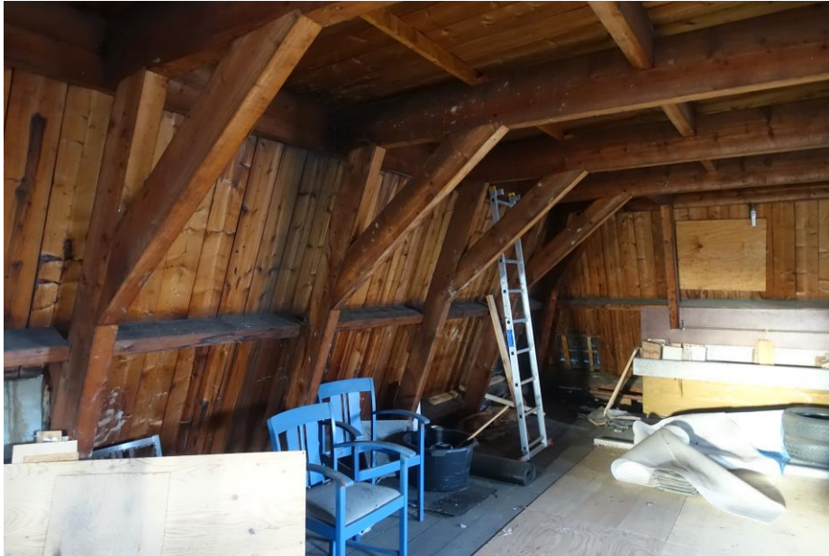
De zolder in de achterbouw naar achteren gezien.
