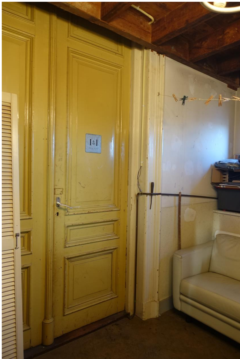
De deuren naar de voorzaal gezien vanuit de overloop van de voormalige secretarie.
