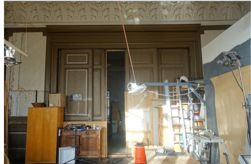
De schuifdeuren tussen de twee zalen op de verdieping. FH MAB 2018
