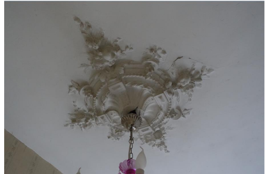
Rozet (oorspronkelijk van plafond overloop, die na invoeging van een tussenverdieping in een kamer is komen te liggen).
