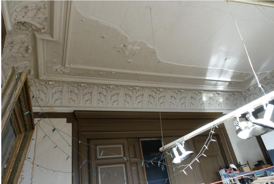
Het stucplafond van de voorzaal. Het middenveld met rozet is verwoest.
