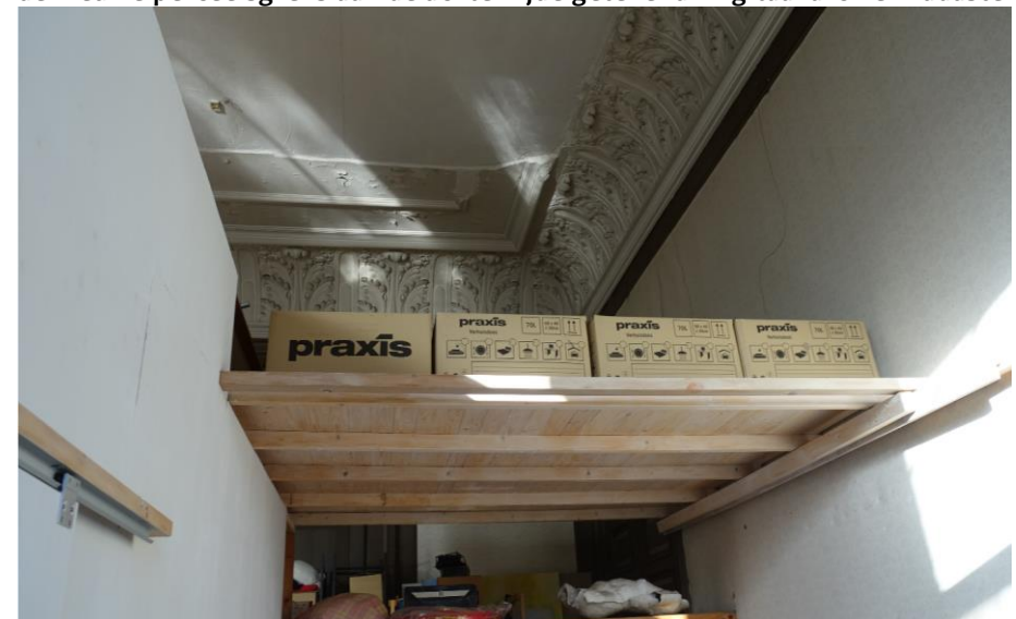
Een in de grote voorzaal gedurende de krakersperiode aangebrachte wand en balklaag.
