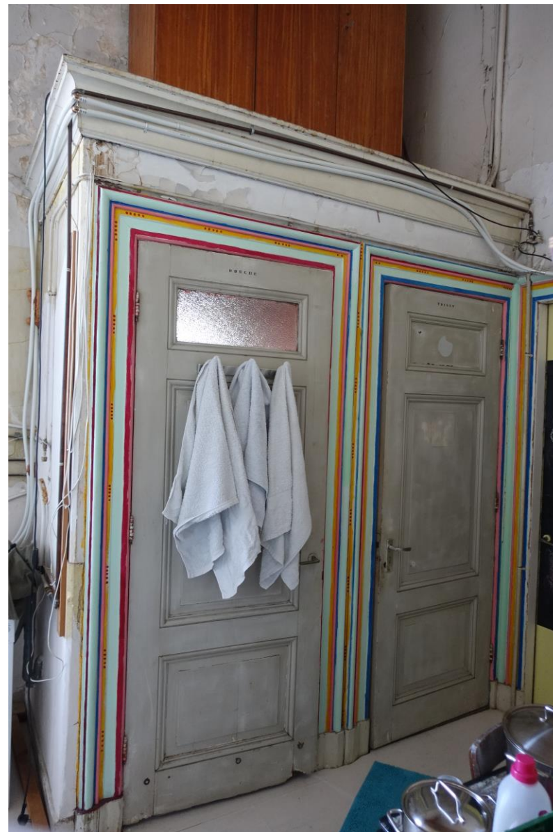
Toilettenblok tegen achtergevel op overloop van de achterbouw.
