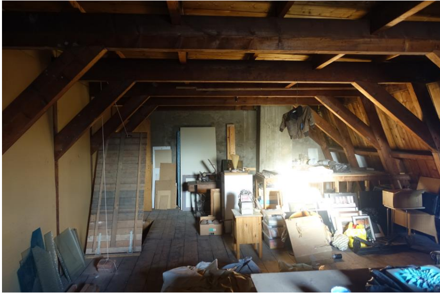
Zolder rechter deel naar achteren gezien.
