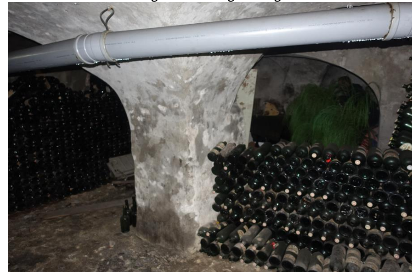
Rechter deel van de kelder met de centrale pijler gezien vanuit de rechter achterhoek. FH MAB 2018
