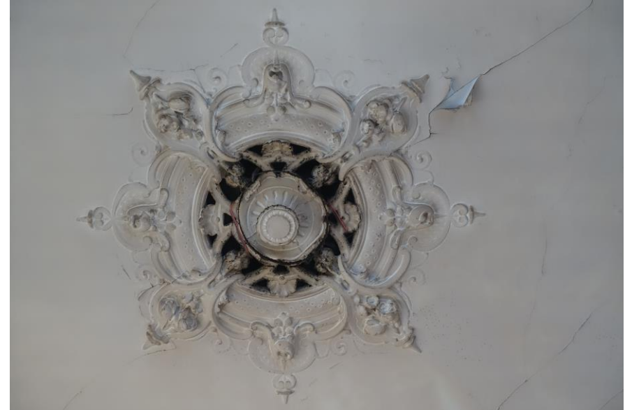
Het centrale rozet met ventilatieopeningen van het stucplafond in de achterzaal.
