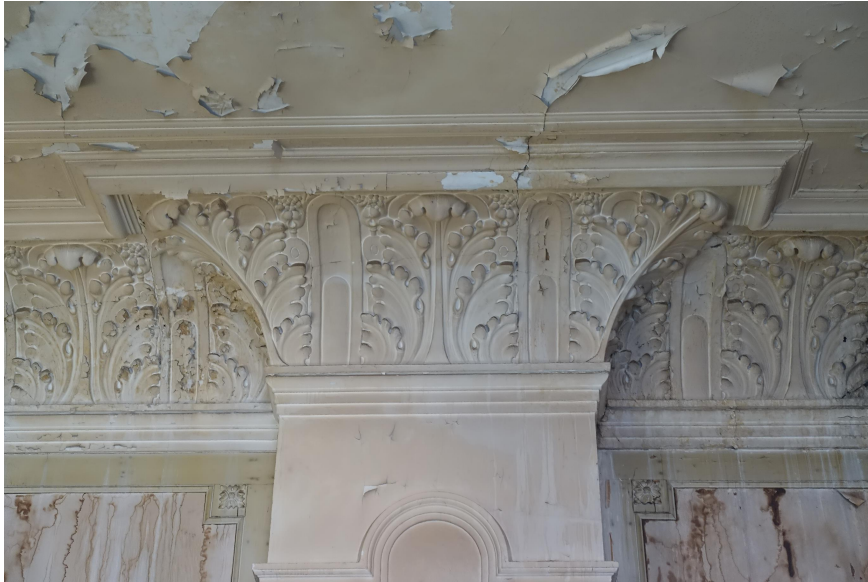
Detail kooflijst ter hoogte van de schouwboezem in de achterzaal.
