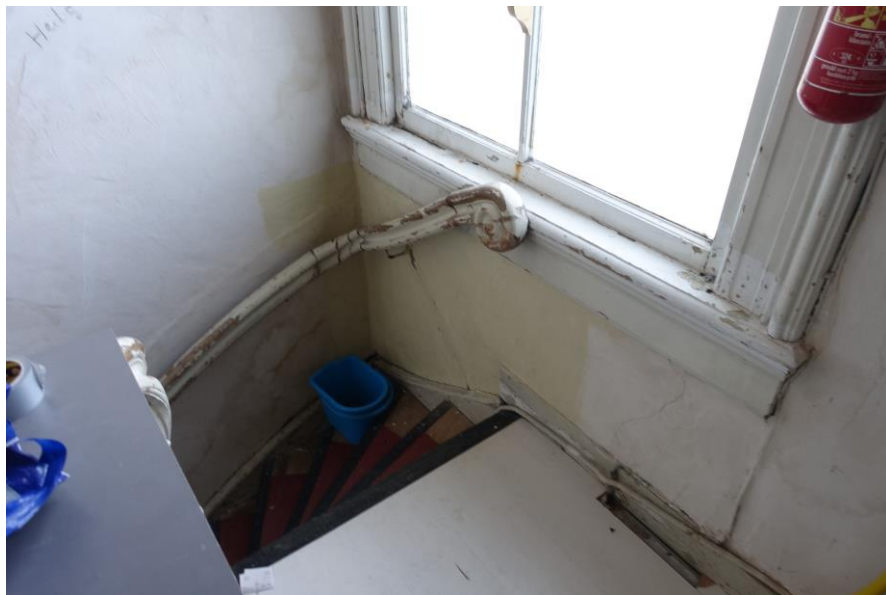
Aansluiting trap op overloop in achterbouw.
