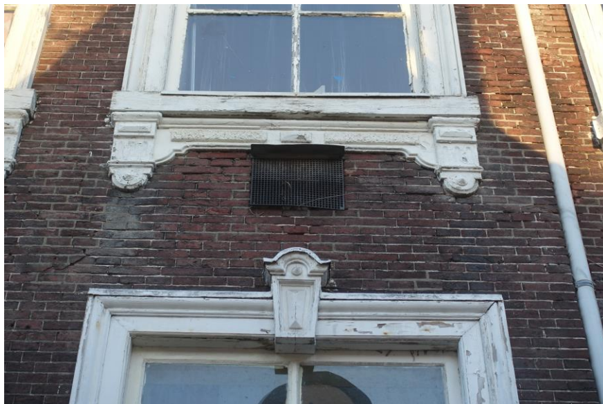
Decoratie onder de verdiepingvensters.
