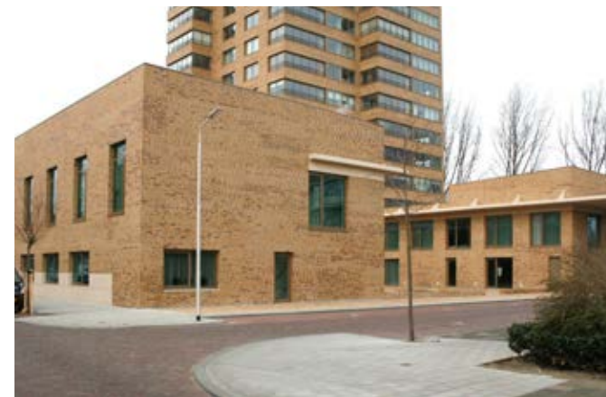
Referentie bebouwing Europawegzone Geurst & Schulze, Vermeertoren Delft
