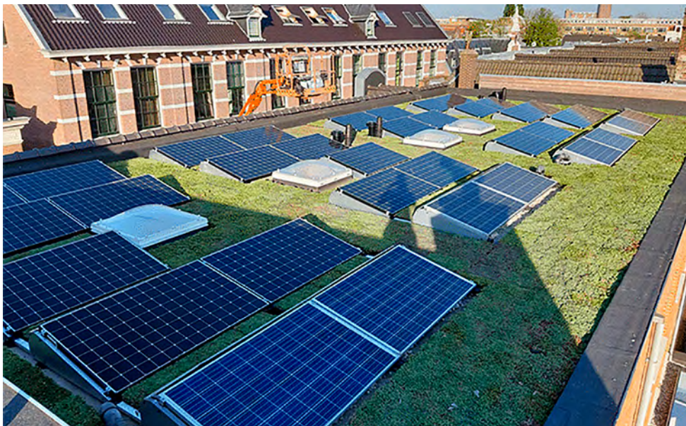
Groen dak met zonnepanelen
