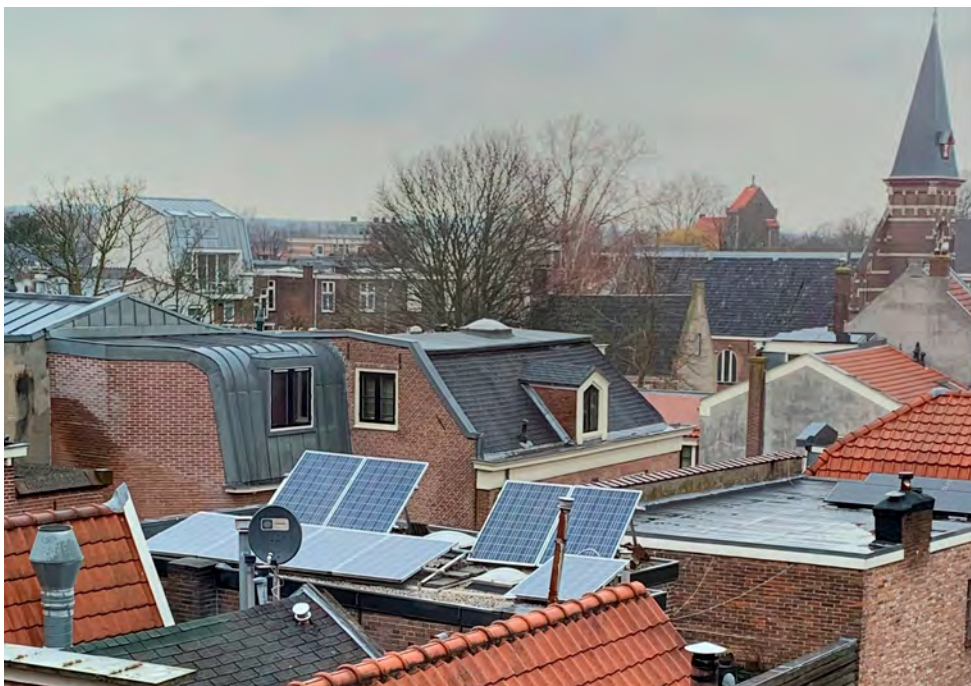
Panelen op platte daken in binnenstad
