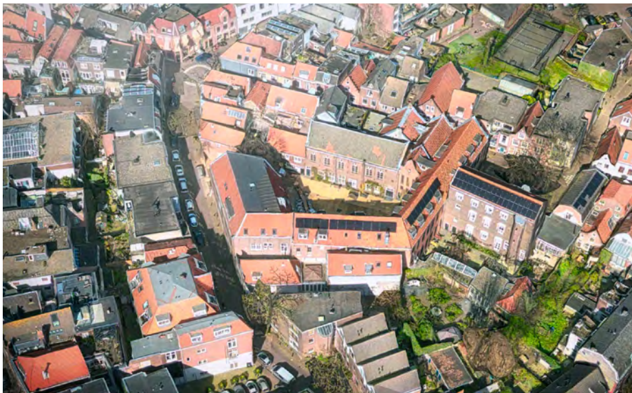
Panelen op schuine daken uit het zicht, Rosenstock-Huessy Huis aan de Antoniestraat
