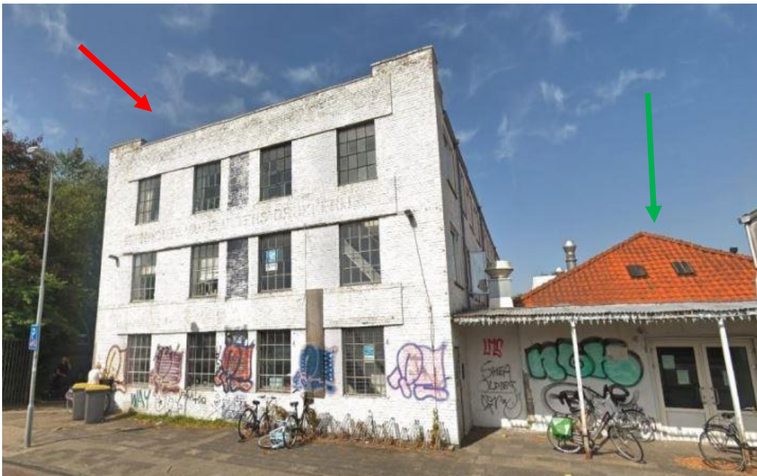
Figuur 25: Het werkgebied voor de sloop. De voormalig drukkerij (links, rode pijl) staat op dit moment nog overeind. Het gebouw recht (groene pijl) is reeds gesloopt. Bron: Google Maps.
