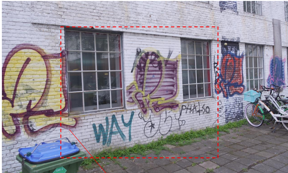
De voorgevel is op de begane grond aan de zuidzijde voorzien van nieuw metselwerk, opgemetseld met machinaal gefabriceerde bakstenen.
