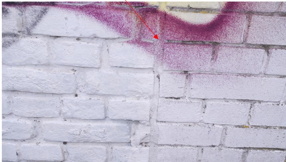
Detail van de overgang tussen oorspronkelijke bakstenen en machinale bakstenen.
