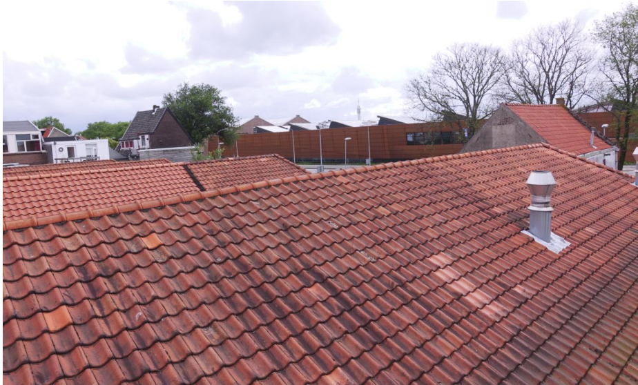
Zicht over het voormalige terrein gezien vanaf de tweede verdieping richting de Oostvest.
