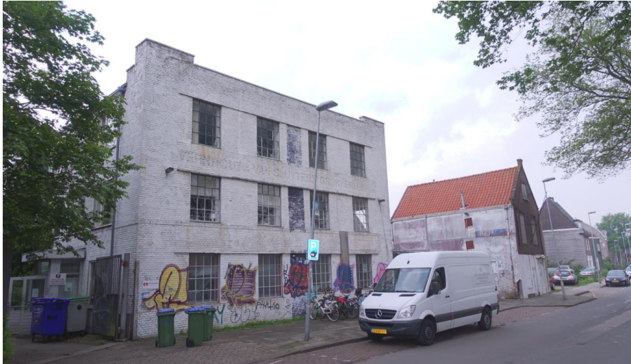
De voorgevel aan de Oostvest.
