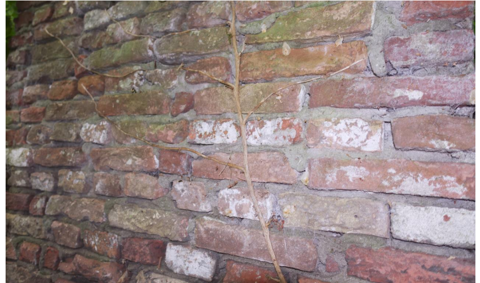
Detail van de hergebruikte bakstenen in de erfscheidingsmuur aan de Oostvest, waarvan sommige stenen een witte afwerking hebben.
