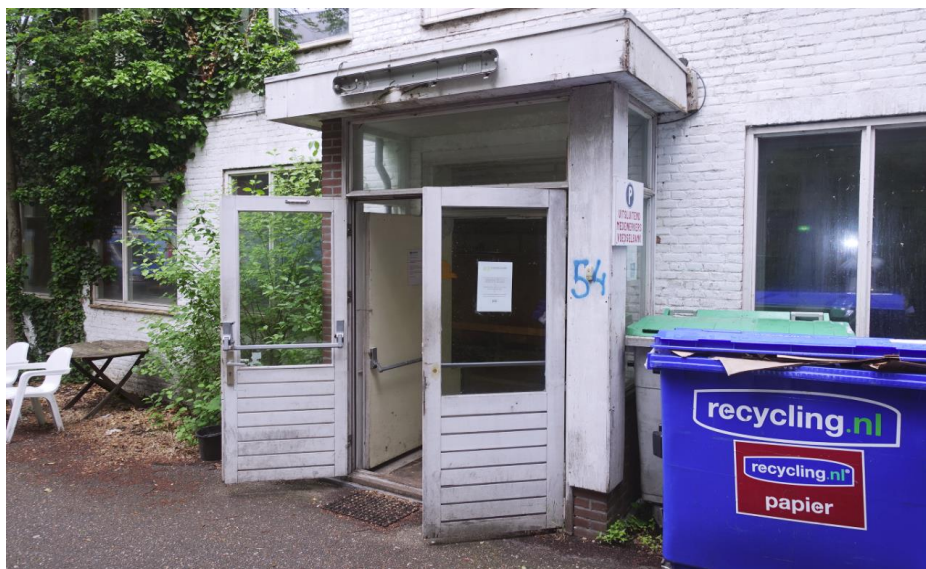
Zicht op het portaal met entree van na 1954. Het plat dak heeft een omlijsting van trespak gekregen.
