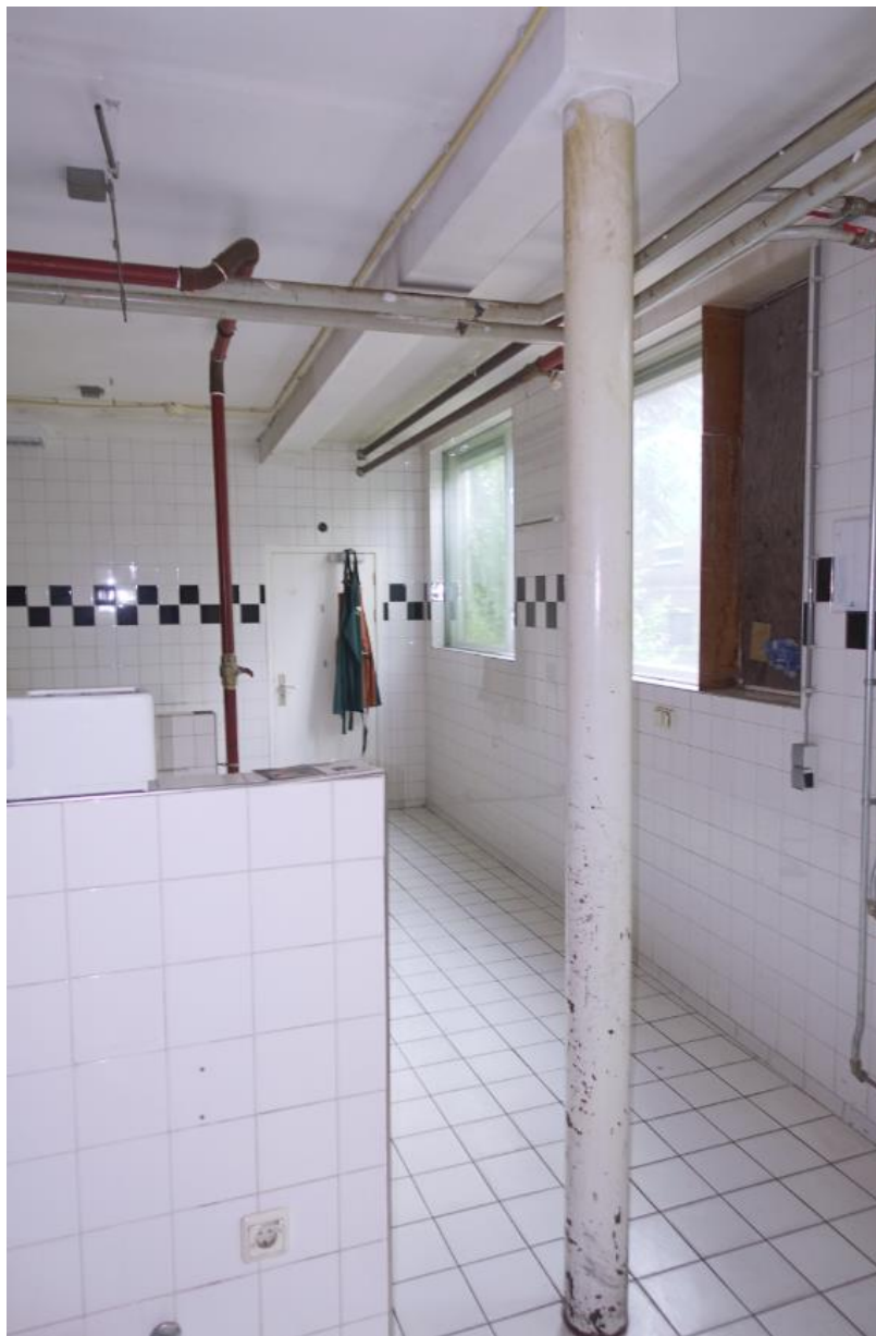
Zicht op de ondersteuning uit 1954 op de begane grond in het achterste deel.
