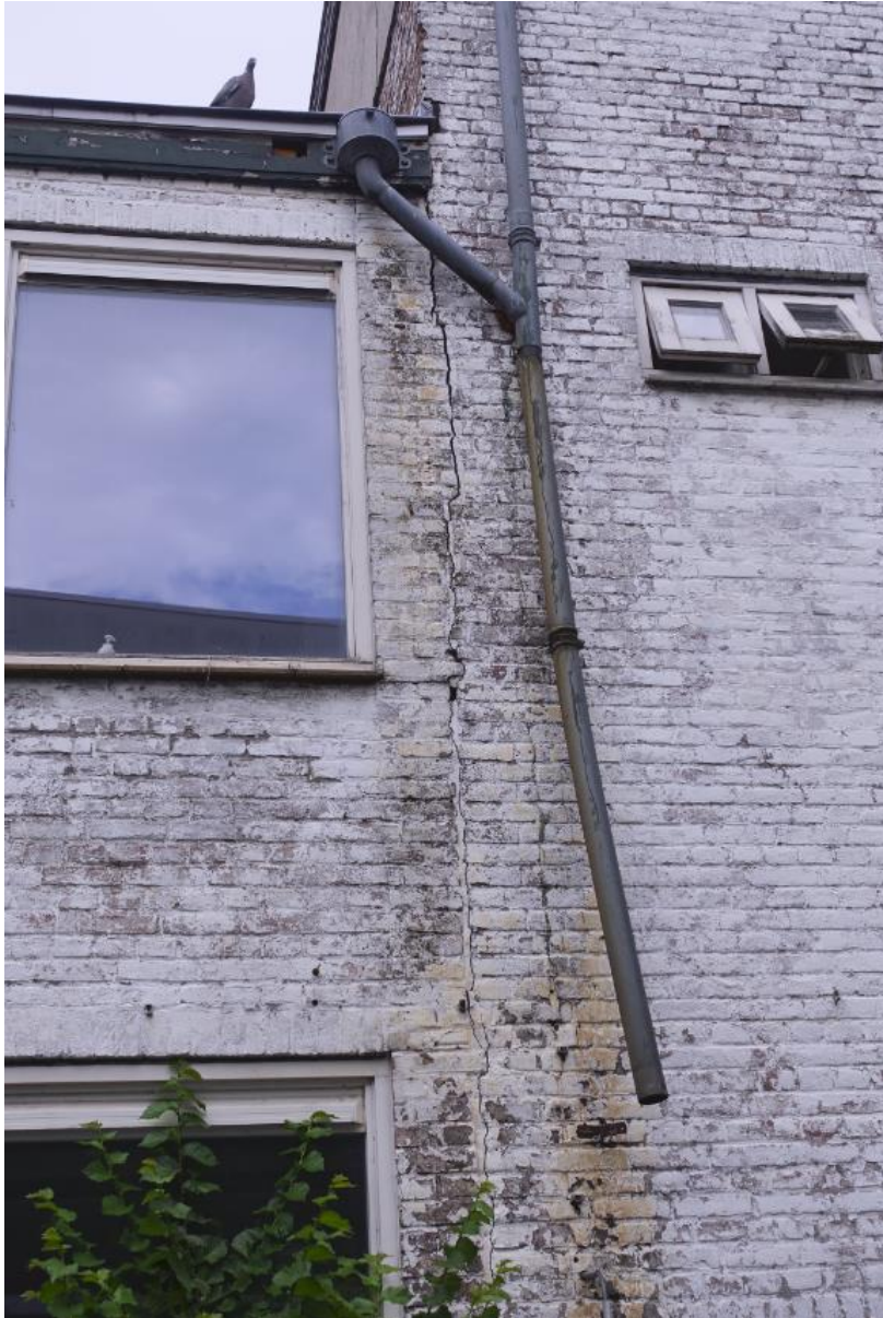
De overgang tussen het muurwerk van voorste en achterste deel is goed zichtbaar bij de bouwnaad in de zuidelijke gevel.
