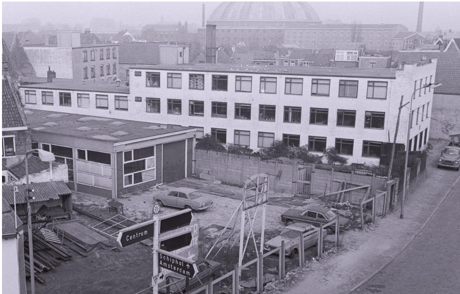
Zicht op de zuidgevel van het bouwdeel uit 1928 en 1935 op een foto van 1972. NHA beeldbank, nr. NL-HlmNHA_JosF19720225_071.
