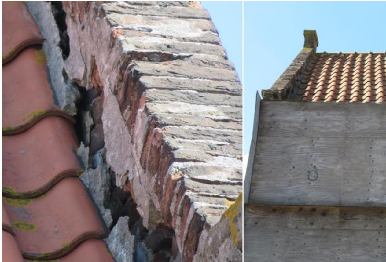
Onderzochte kier tussen gevel en dak, die geen toegang geeft tot een mogelijk verblijf
