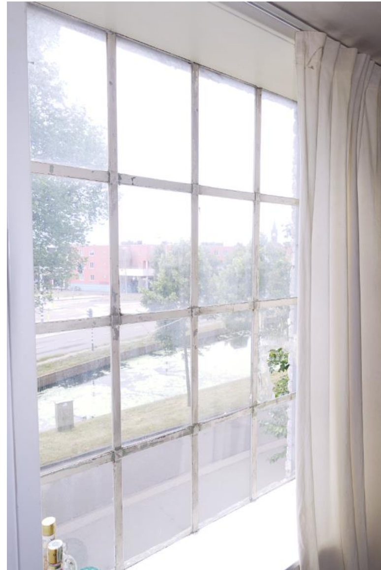
Een van de vensters in de voorgevel op de tweede verdieping met stalen vulling, gezien van binnenuit.
