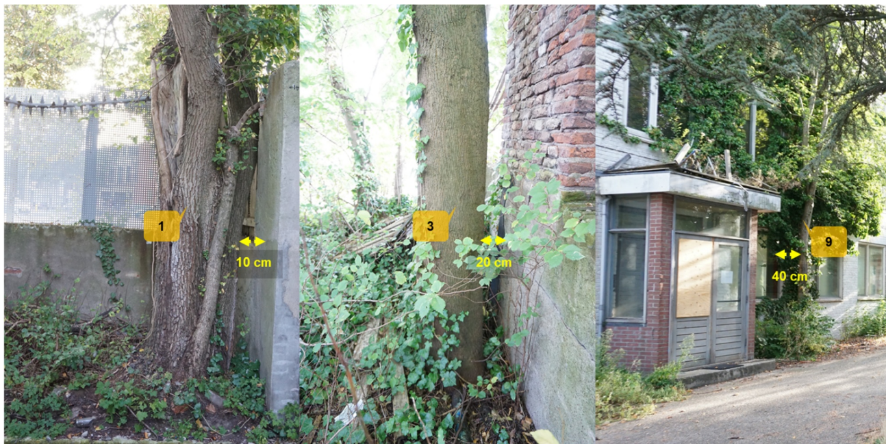
Foto 4: Bomen die dicht tegen een gevel of erfgrensafscheiding staan. Met een gele pijl is de afstand tussen obstakel en stam weergegeven.
