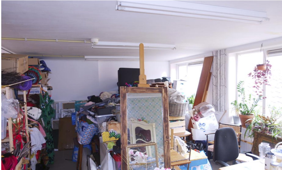
Zicht op een van de ruimtes op de verdieping tegen de noordgevel van het voorste deel.
