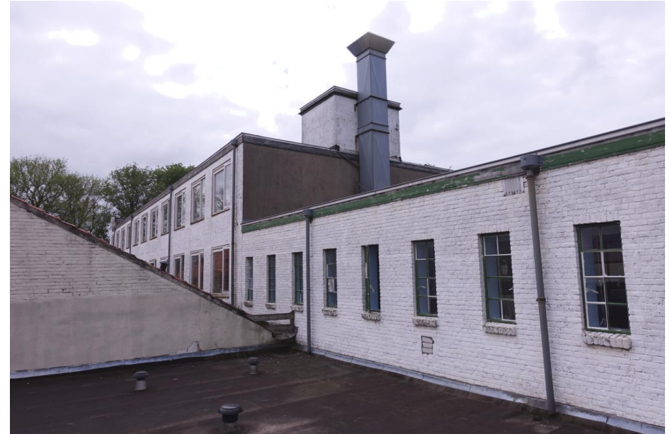
Zicht op de noordgevel met de aansluiting van het hogere vooste deel met het lagere achterste deel. De begane grond is hier geheel overbouwd.
