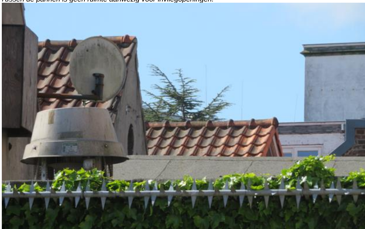
Detailfoto nokken van puntdaken. Vast gemetseld en zonder kieren.
