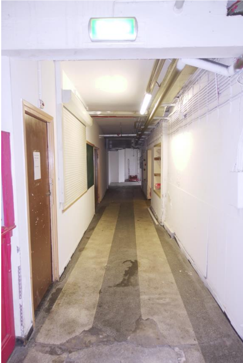
De gang tegen de noordgevel die de ruimtes in het achterste deel ontsluit, gezien richting de Houtmarkt.
