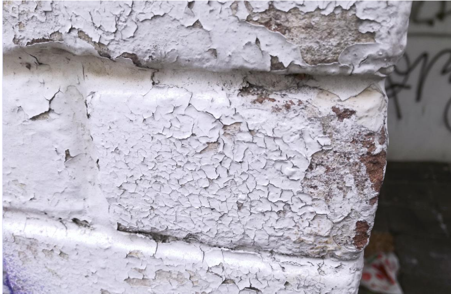
Detail van het metselwerk van de voorgevel met verschillende lagen witte verf.
