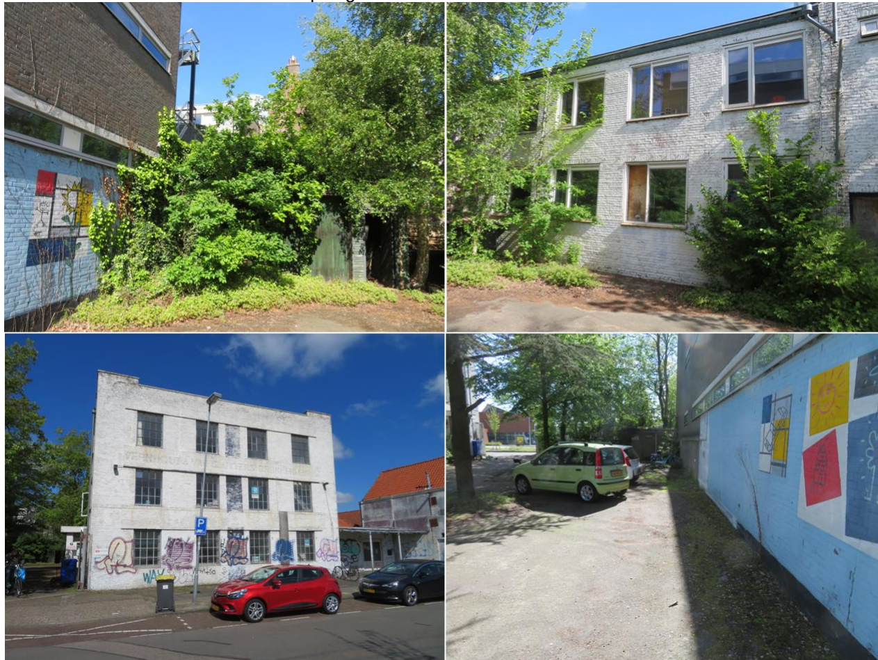
Gebouw voedselbank met vervallen schuur en parkeerplaatsen voor medewerkers.
