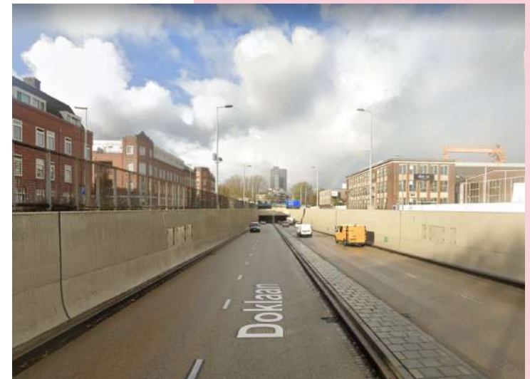
Voorbeeld 2: tunnelmond van de Maastunnel, Rotterdam
