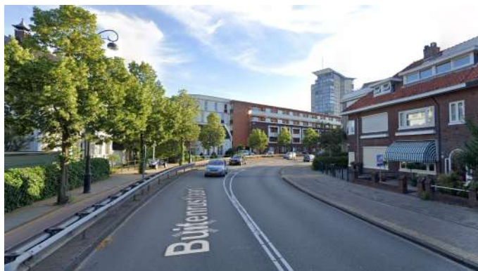
Buitenrustlaan: het smalle deel van de N205 (één rijstrook per richting, een vangrail en woningen
