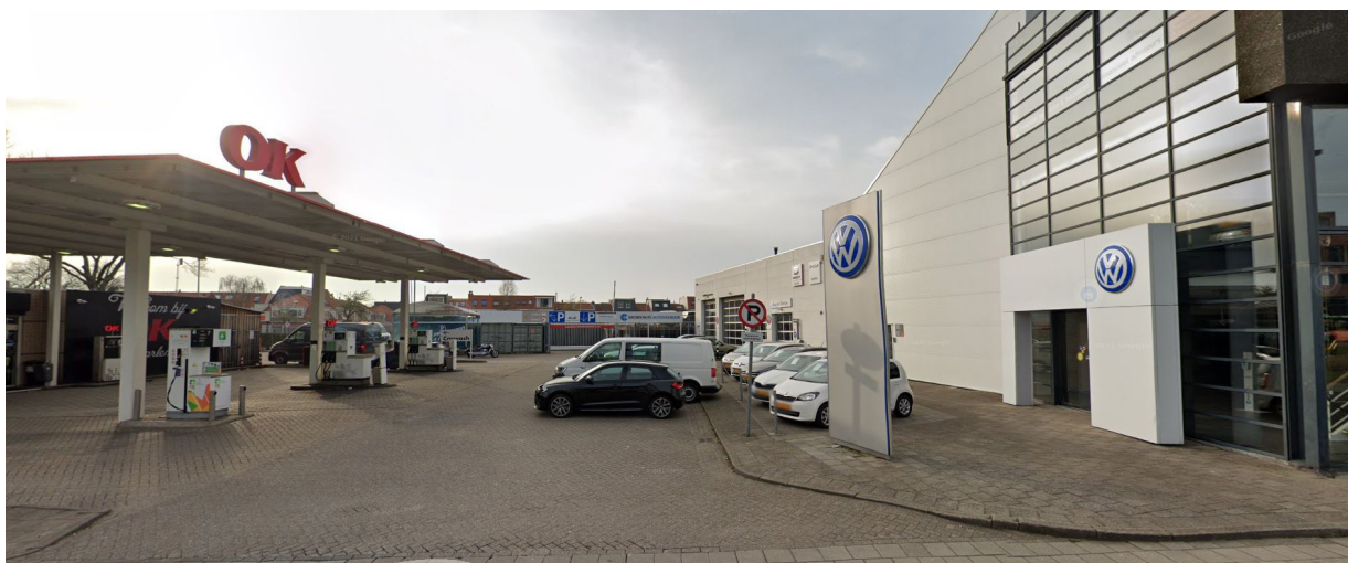
Zicht parkeergarage vanaf Leidsevaart bestaande situatie
