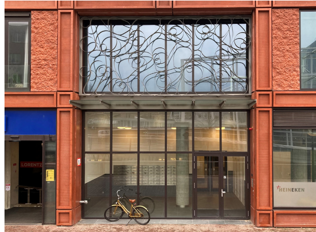
Tochtportaal met brievenbussen aan binnenkant ('s avond afgesloten)
