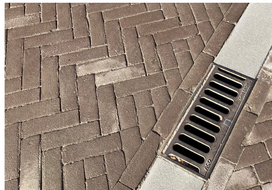
Verharding fase 1 - bruine, gebakken klinker
