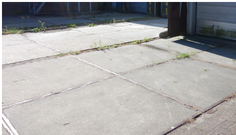
betonplaten op het terrein
