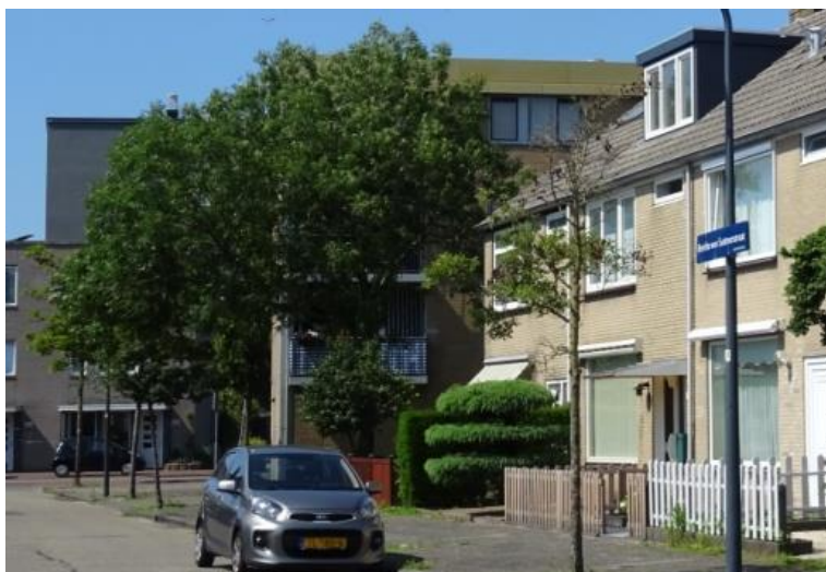
Boom met een zeer slechte conditie in de Bertha von Suttnerstraat
