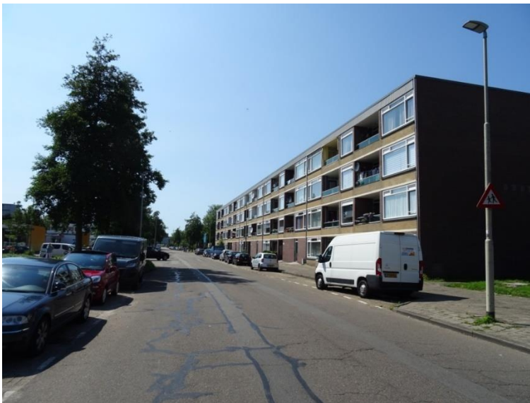
Stresemanlaan; onvolledige structuur
