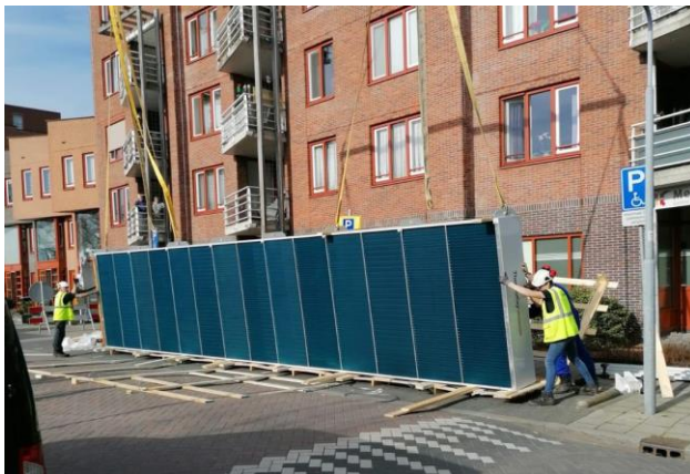
Figuur 10 - Droge koeler 7 voor de regeneratie van een wko voor 244 (zorg)woningen
