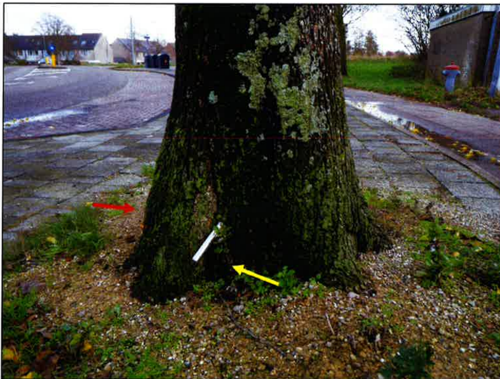
Foto 58: Rechts een beeld van de inrotting, de prikstok verdwijnt diagonaal in de stamvoet (gele pijl). De rode pijl geeft de andere zijde met inrotting aan.
