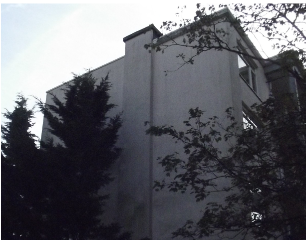
zijgevel Staalstraat 2 schuilplaats baltsend mannetje ruige dwergvleermuis dwergvleermuis
