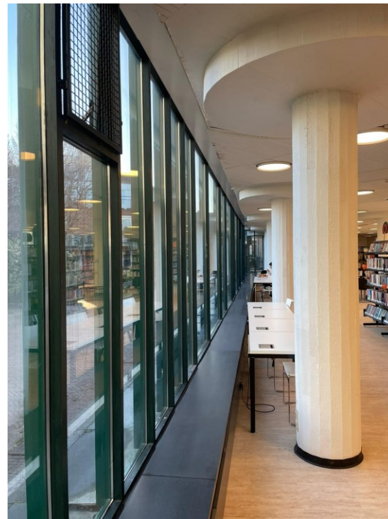
Nieuw HR++glas gevel
