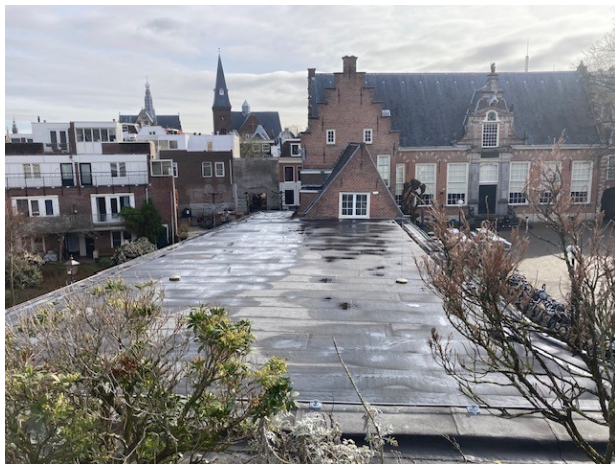
Nieuwe dakbedekking met verbeterde isolatie ( R_c = 6,0 W/m^2 )
