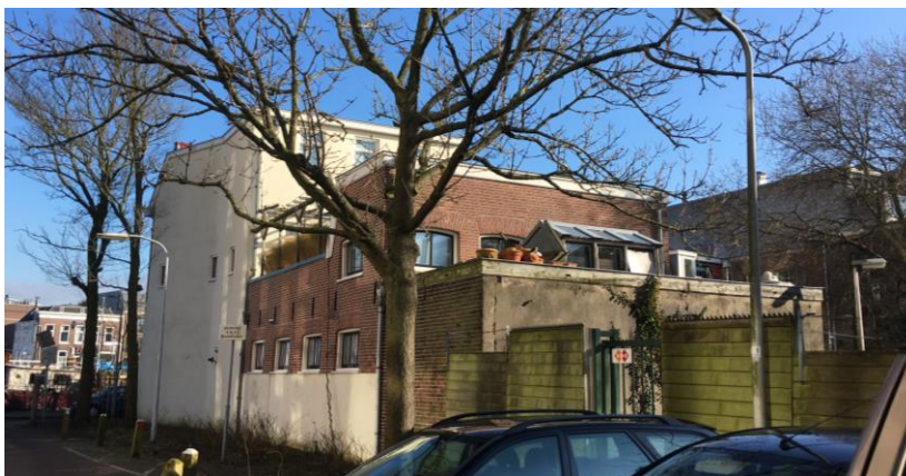
Achterzijde nummer 24 met vm machinekamer
