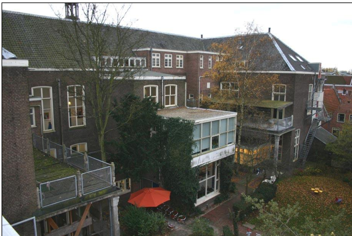
Afb. 22) De achterzijde van het hoofdgebouw, gezien vanuit het noordoosten. De oorspronkelijke architectuur van het hoofdgebouw uit 1871 is aan deze zijde door aanpassingen in verschillende perioden minder goed herkenbaar. De gevelopeningen met getoogde bovenzijde en 8-ruits ramen maken deel uit van de 19 de -eeuwse opzet. Bij de westelijk zijvleugel kan de indeling van de noordgevel aan de hand van bouwsporen worden gereconstrueerd. Deze bestond uit twee vensters op elke bouwlaag, waarbij de oostelijke op de verdieping boven de westelijke op de begane grond was geplaatst. Dit venster op de begane grond is naderhand dichtgemetseld (A). Op de verdieping is het westelijke venster verbouwd tot nooduitgang, maar bestond in opzet vermoedelijk enkel uit een bovenlicht. Het gepleisterde metselwerk eronder (B) verwijst naar een uitbouw die hier in opzet aanwezig was. Tegen de binnenzijden van de zijvleugels zijn in 1924 balkons aangebracht (C, afb. 9). Daarbij zijn de twee oorspronkelijke vensteropeningen op de verdieping verbouwd tot doorgang. De 19 de -eeuwse bovenramen lijken daarbij te zijn gehandhaafd. Vermoedelijk in het derde kwart van de 20 ste eeuw is de ruimte onder de balkons gedeeltelijk ingevuld (D) en ook het balkon achter het hoofdtrappenhuis overbouwd (E). In 1917 is de toiletuitbouwen (F, afb. 5) verbreed en vervolgens in 1954 opgehoogd (G, afb. 15).
