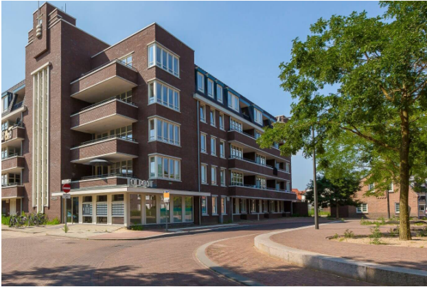
Hoekaccenten, heldere toegangspartijen, erkers en diepte in de gevel
