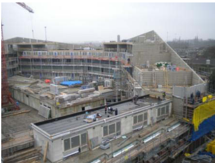
Slauerhof in aanbouw
