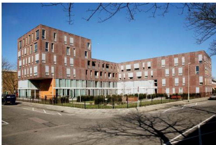
Nieuwbouwproject Loevestein in Haarlem
