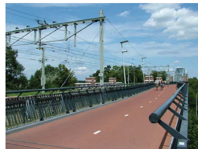
FIETSBRUG NAAST HET SPOOR, NIJMEGEN
