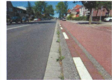
afbeelding 20 Schuine band is hoog en sluit niet netjes aan op rijbaan
