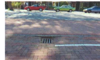
afbeelding 23 Straatkolk ligt lager; bestrating sluit niet goed aan
