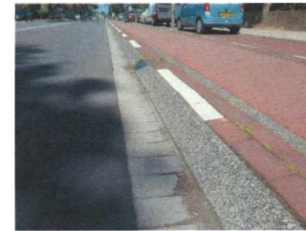
afbeelding 19 Schuine band is hoog en sluit niet netjes aan op rijbaan
