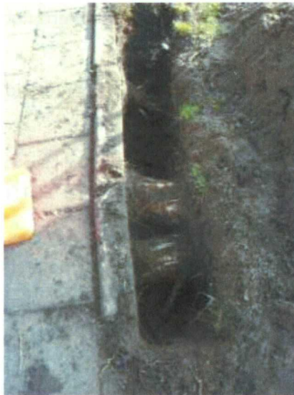
Foto 4: Dikke oppervlakkig gegroeide wortels onder de verharding
