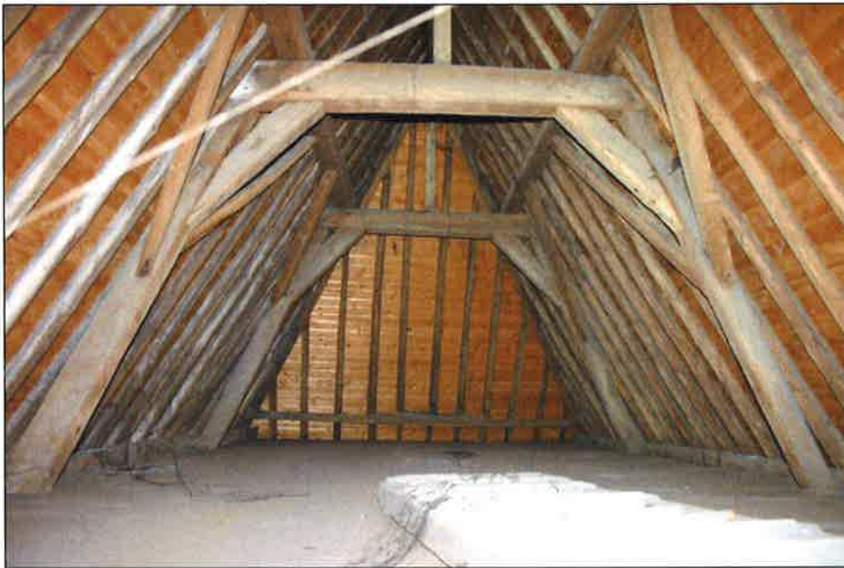
Afb. 18) De zolder (boven) en vloering (onder) van het noordelijke huis, gezien naar het noordoosten. De constructie van de kap boven dit huis bestaat uit twee gestapelde dekbalkjukkan van grenenhout. De combinatie van vorm en materiaal dateert de constructie in het begin van de 17 de eeuw. Alleen voor het windverband is eikenhout toegepast. Op het bovenste juk staat een nokstijl. Dit element en de vorm van de telmerken zijn het enige verschil met de kapconstructie boven het zuidelijke huis.
