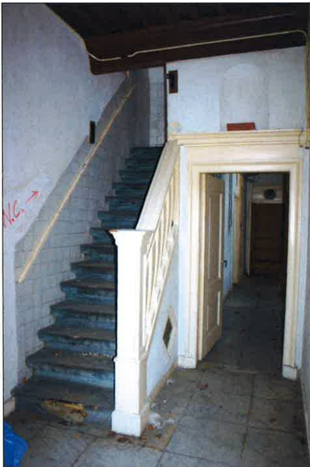
Afb. 11) De bordestrap naar de verdieping in het noordelijke huis (links) en een detail van de balusters langs de onderste steek van de trap (rechts). De trap kan op grond van de vormgeving van de balusters in de 17 de eeuw worden gedateerd. Het zou dan in samenhang met consoles in de gang van het noordelijke huis om het tweede kwart kunnen gaan. Gezien de ongelijke breedte van de steken is de trap waarschijnlijk in een bestaande structuur ingepast. Dit zou betekenen dat het oostelijke deel van de gang bij de eerste opzet van het gebouw behoort.
