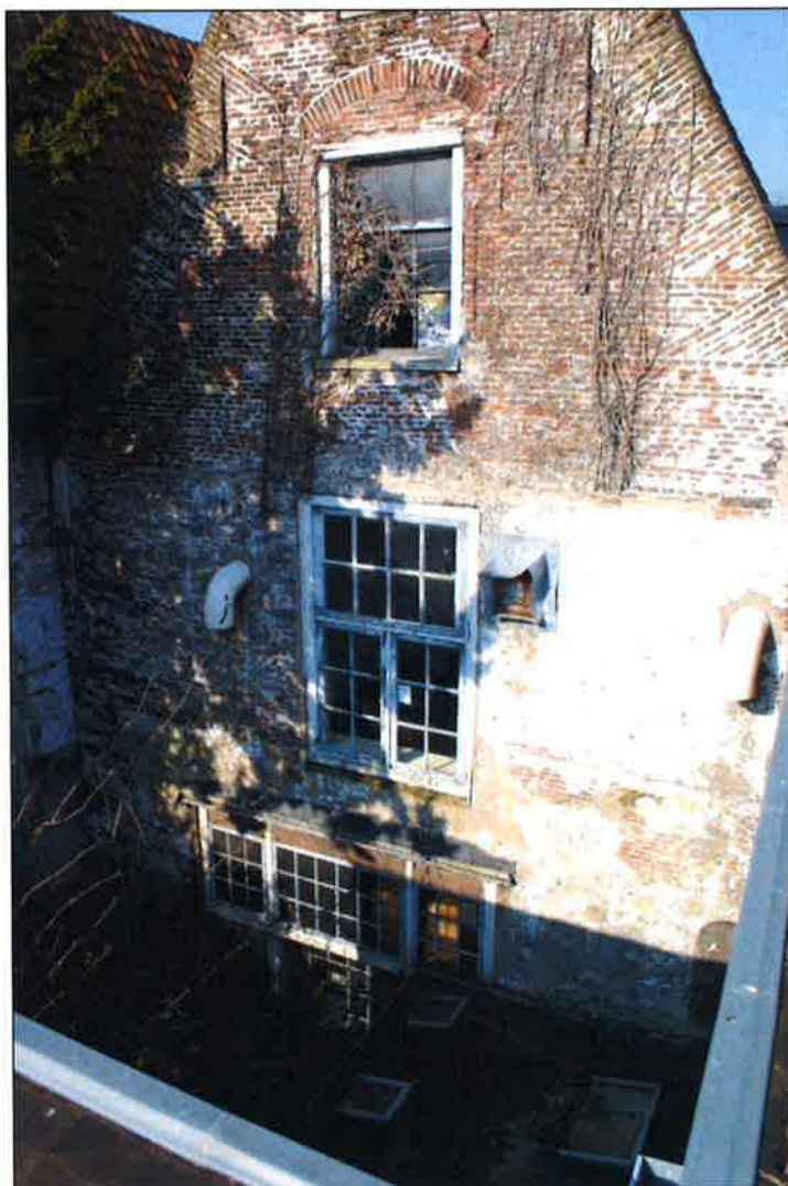
Afb. 10) Overzicht van de achtergevel van het zuidelijke huis. Deze tuitgevel dateert gelijktijdig met de 17 de -eeuwse voorgevel. Dat de zuidgevel van Houtmarkt 7 ouder zou kunnen zijn, kan worden opgemaakt uit een verticale naad bij de aansluiting met Houtmarkt 9 (A), die vermoedelijk verband houdt met een afgesloten druiptrook. In de gevel zijn verschillende wijzigingen zichtbaar, zoals het versmallen van het zoldervenster (B). Bij het verdiepingsvenster is voor het vermoedelijk 18 de -eeuwse kozijn de ontlastingsboog aan de bovenzijde verwijderd (C) en de boog boven het begane grondvenster doorsneden (D). Het venster op de begane grond heeft mogelijk een 17 de -eeuws kozijn. Het raam in het onderste deel van het venster zou 18 de -eeuws kunnen zijn. De ramen in het bovenste deel zijn in 1928 vervangen. Boven de ramen is de ruimte opgevuld met machinale bakstenen (E). Aanleiding hiervoor zal het verwijderen van de verdiepingsbalklaag en het aanbrengen van een nieuw plafond in de achterliggende ruimte zijn geweest. Bij de aansluiting met de zuidgevel van het noordelijke huis is een nis zichtbaar (F), die gemaakt is voor het 17 de -eeuwse venster in de gang en wijst op een verdwenen indeling in dit deel van het gebouw.
