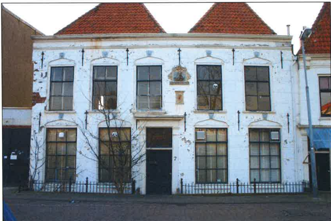
Afb. 9) Overzicht van de voorgevel aan de Houtmarkt. De gevel dateert uit het eerste kwart van de 17 de eeuw, mogelijk rond 1610, en had oorspronkelijk twee trapgevels (afb. 7). Deze opzet blijkt nog uit de ongelijke verdeling van de vensters op de verdieping en een uitkraging bij de noordhoek. De 17 de -eeuwse gevel was uitgevoerd in schoon metselwerk met een kettingen van natuursteenblokken bij de hoeken. Mogelijk in het derde kwart van de 19 de eeuw is de gevel verbouwd tot lijstgevel. Zeker is dat toen de cementpleister is aangebracht en op de begane grond de vensteropeningen zijn vergroot. De ramen, de voordeur en het stoephek dateren ook uit deze periode.
